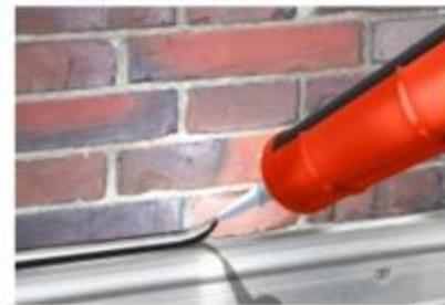
**Figure 6c - Traitement en tête - Cas de la pose sur étanchéité**
